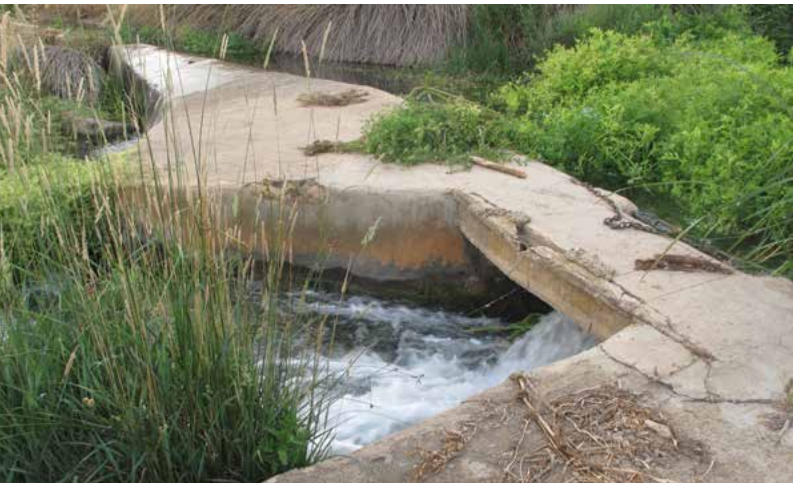
Presas de la Casa Costas, Lezuza
