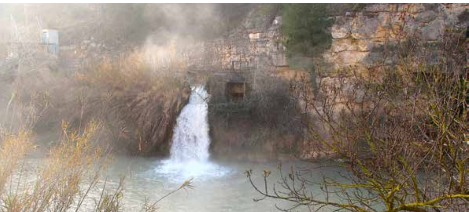
Aliviadero de la acequia de los Dornajos, Jorquera
