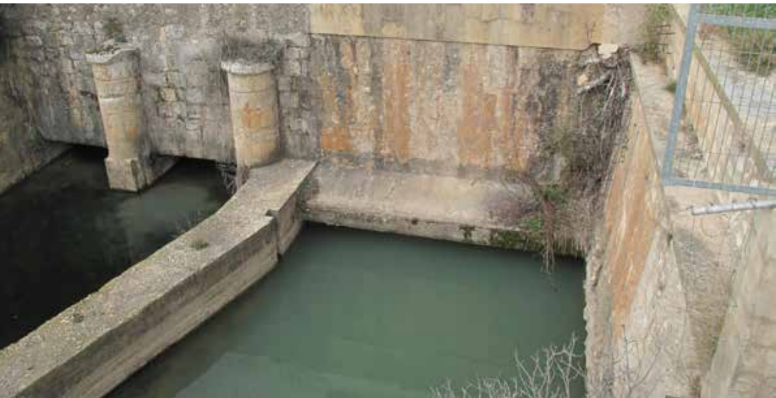
Central Hidroeléctrica de Bolinches, Valdeganga-Mahora
