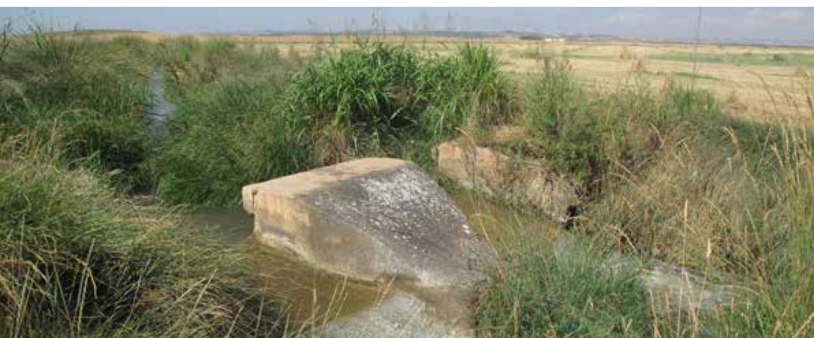
Presa de la Parada Boca Cepo, Barrax. Río Lezuza
