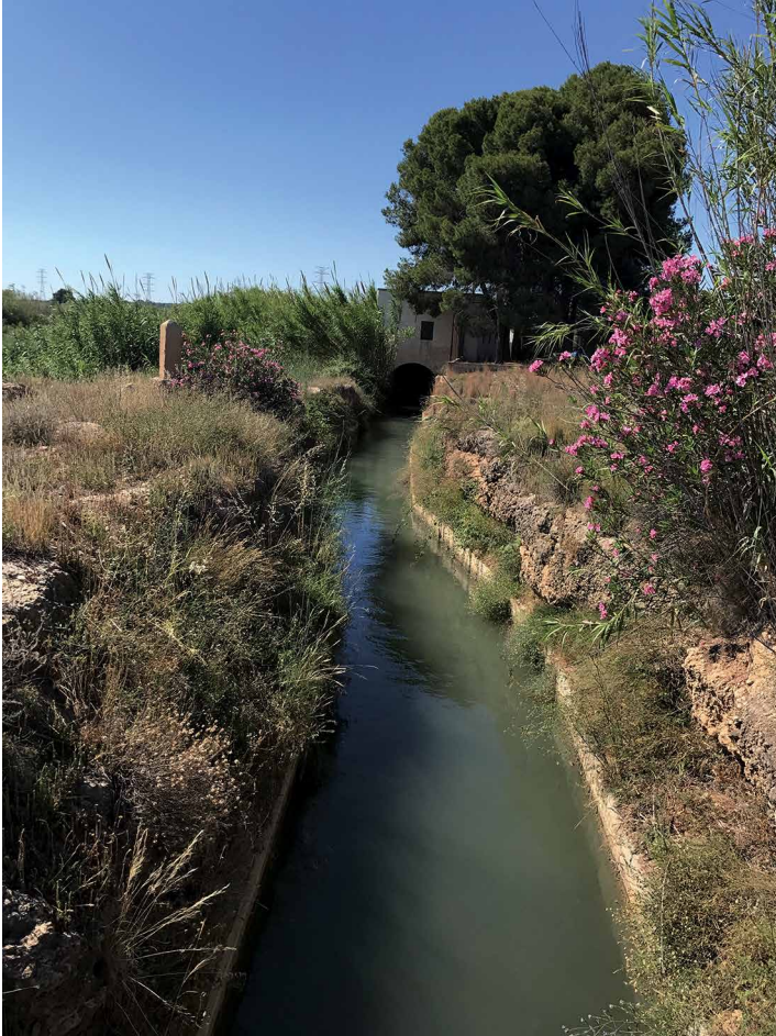
Acequia de Mestalla diversion dam. Casa Partidor
